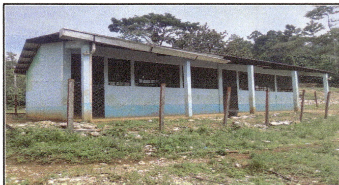
Foto 4: Sustitucion de canales normales por canales cuadrados troqueladas
