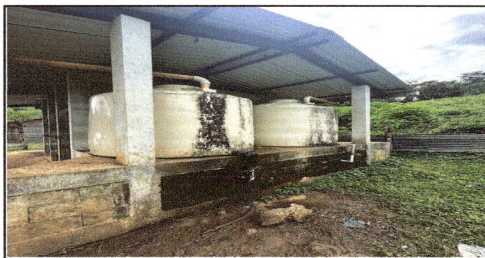
Foto 5: Sustitucion de deposito de agua, tinaco de 2500 litros
