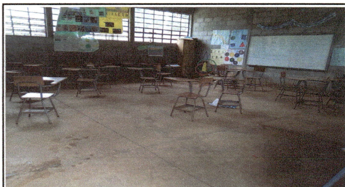
Foto 3: Aplicación de pintura en el interior del Centro Educativo
